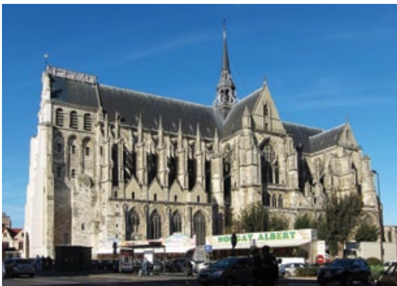
Il. 10. Bazylika w St. Quentin. Źródło: Domena publiczna (W roku 2023 przed bazyliką prowadzone są prace budowlane, sam kościół jest częściowo w rusztowaniach.)
