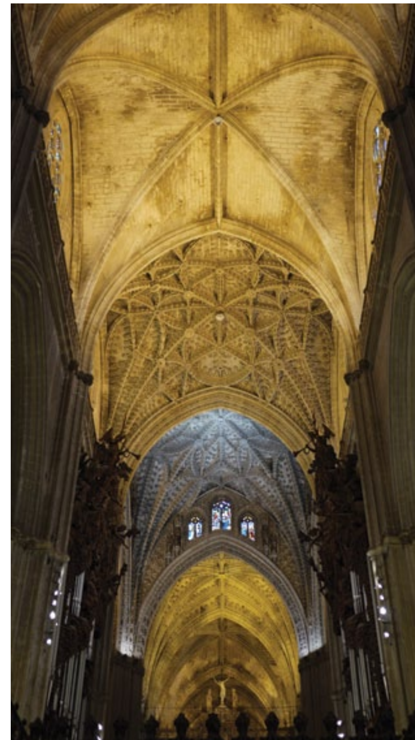
Katedra w Sewilli, Hiszpania. Sklepienie nawy głównej, pięcynawowej świątyni o szerokości 116 m. Fot. K. Zisopulu
