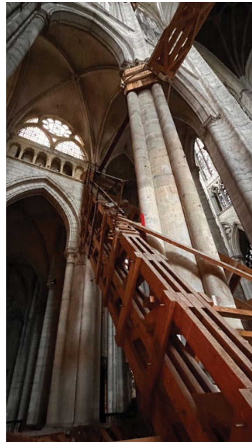
Katedra w Beauvais, Francja. Drewniane konstrukcje podtrzymujące filary. Fot. K. Zisopulu
