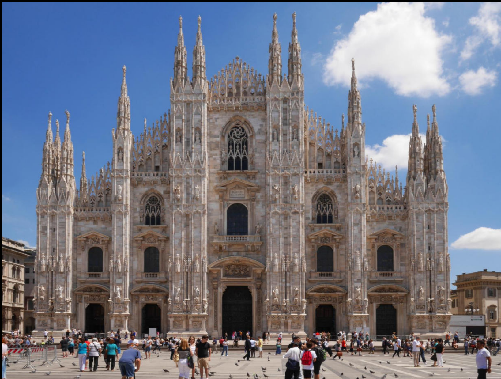
Katedra Narodzin św. Marii – budowa 1396 -1861 r.
