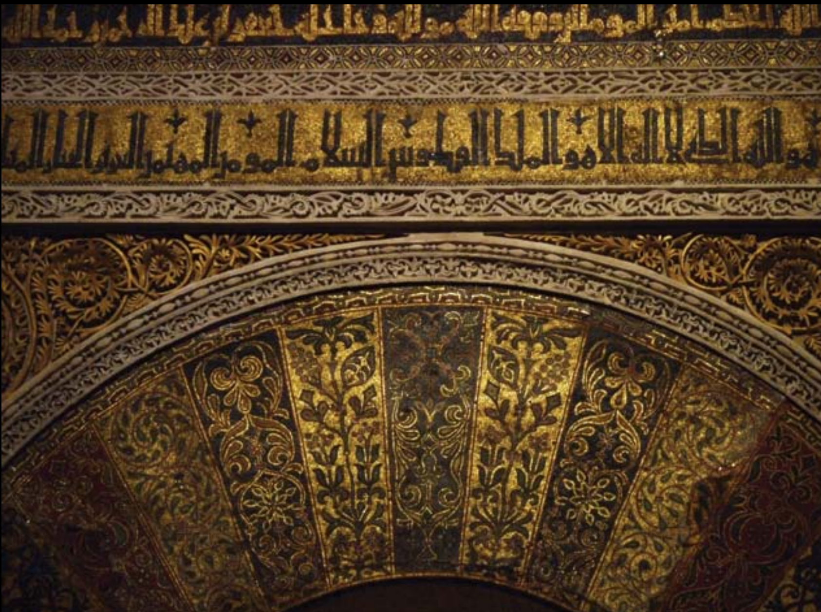
Łuk mihrabu Wielkiego Meczetu, czoło łuku zdobią klińce dekorowane mozaikami, powyżej umieszczono wersety z Koranu.
