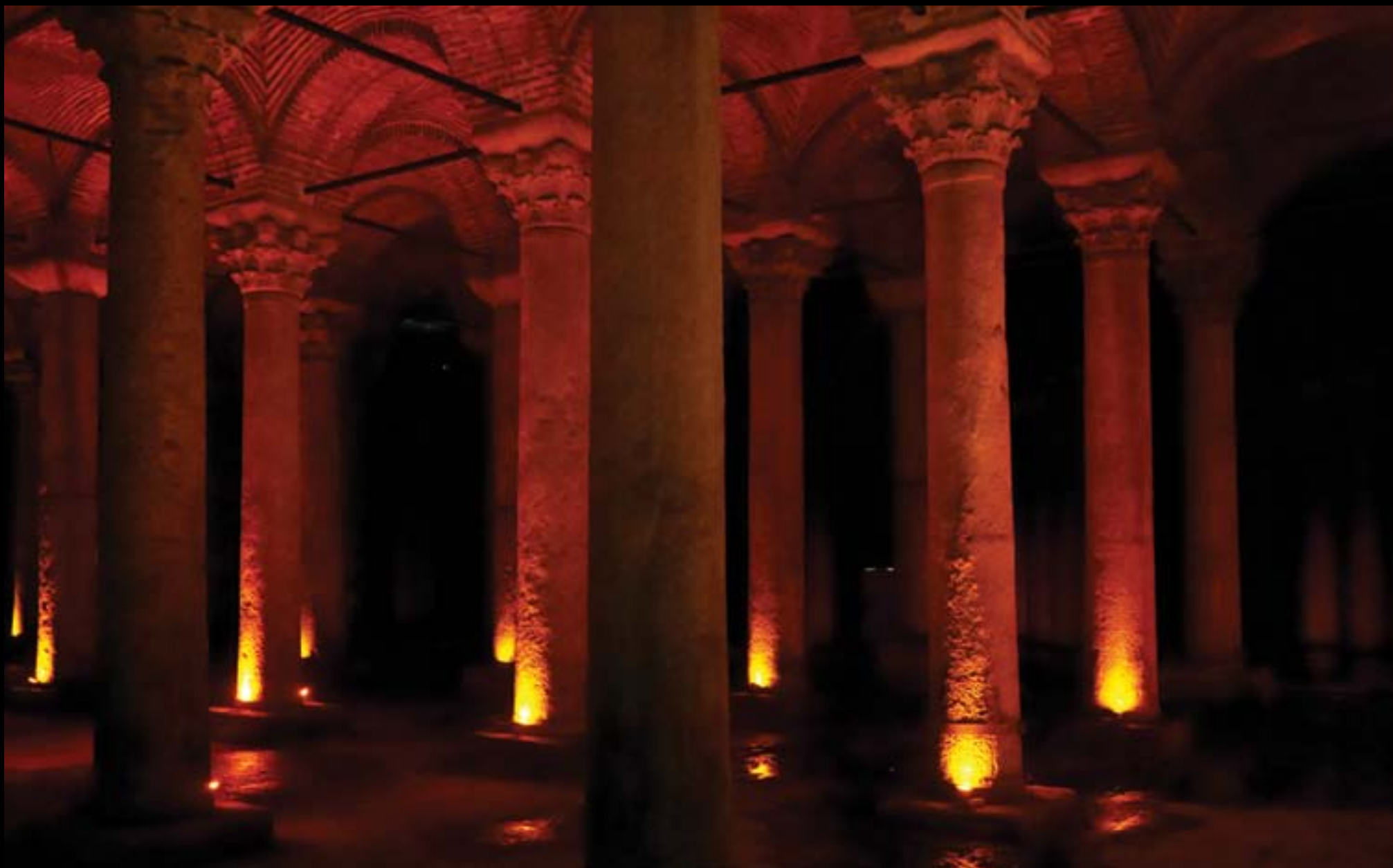
Cysterna Bazylikowa, VI w., podziemny zbiornik wody o pojemności 80 tys. m 3
